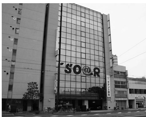
ソアラビジネスポートの入っているビル
