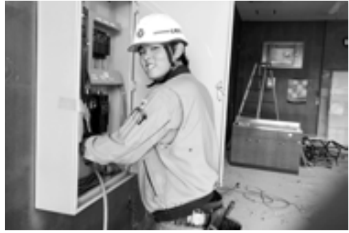
電気工事作業
