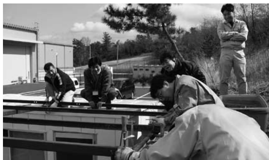
「建設の日」の休憩所づくり
