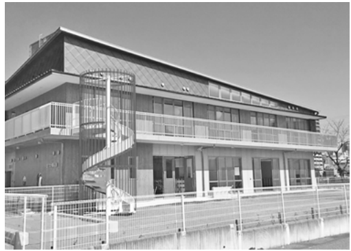
地中熱空調・床暖房システムを導入した 認可保育園（さいたま市大宮区）
